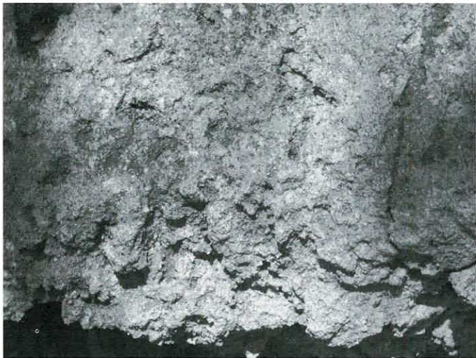
Figura 3 La calcarenite nella zona di Martella sopra l'abitato della frazione di Cavo.
