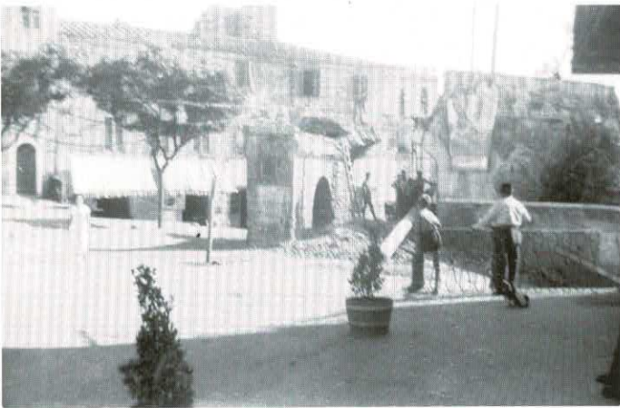
I lavori di demolizione.
