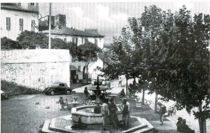
Gli Archi dopo la demolizione.
