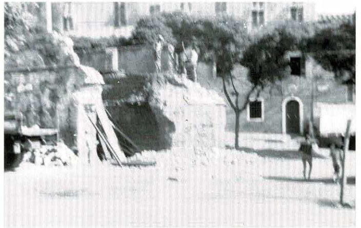
I lavori di demolizione.
