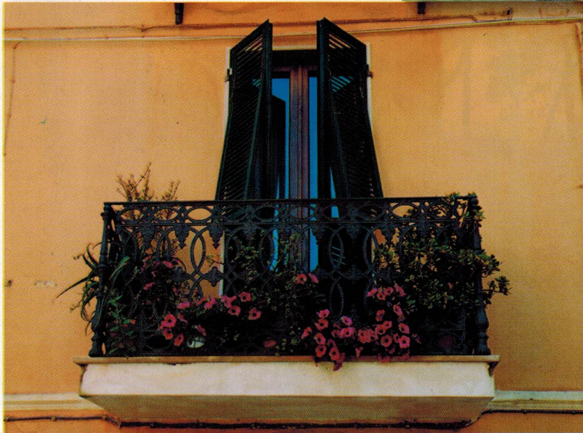
Rio Marina via XX Settembre - Il balcone di Vanna. (Foto P. Leoni)
