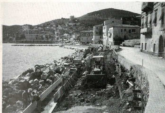
I lavori di ampliamento della strada del Sasso.
