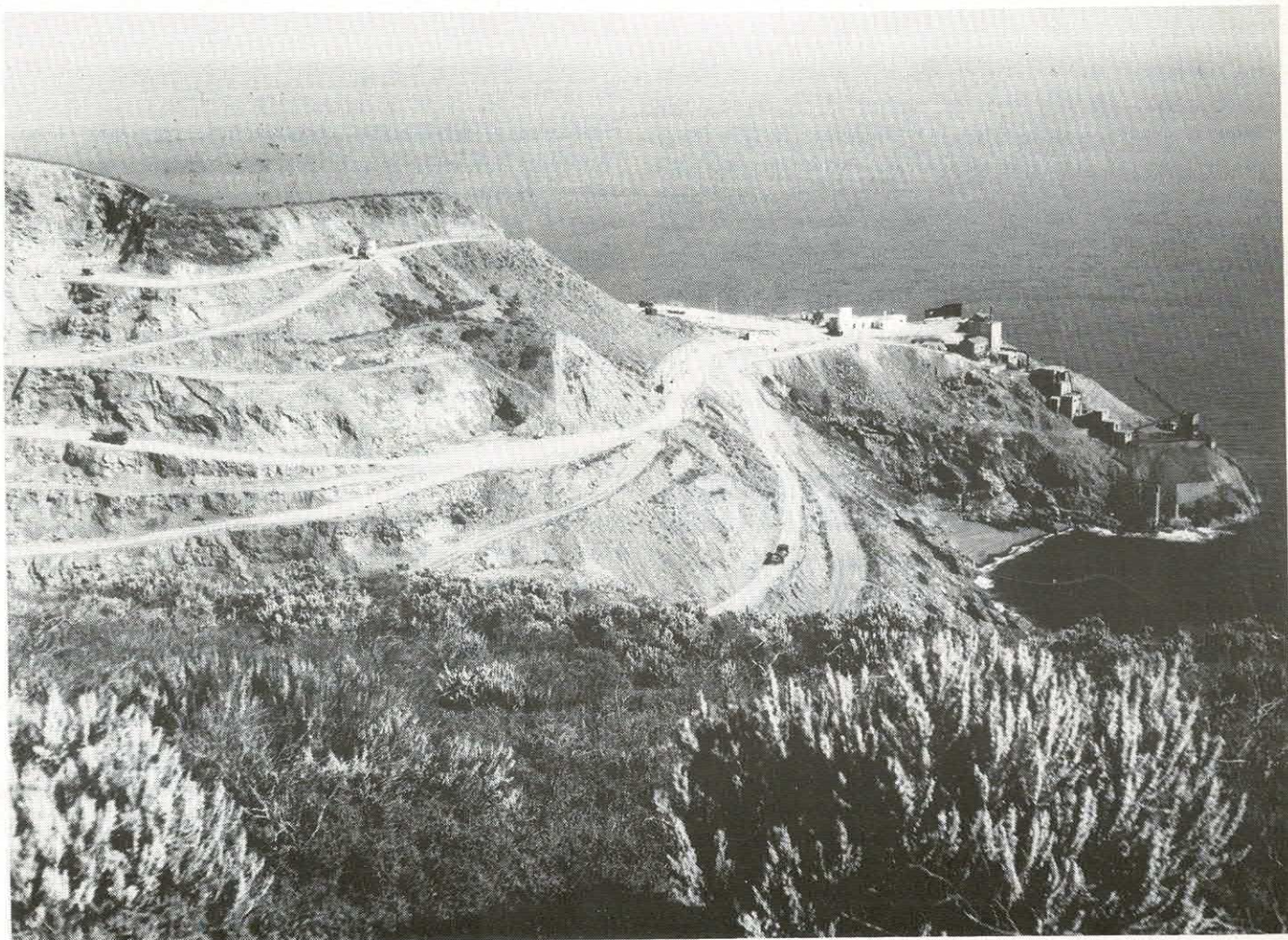
Miniera di Calamita (Capoliveri) - Cantiere Ginevra: veduta d'insieme dell'impianto di trattamento e della miniera.
